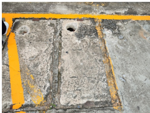
ภาพที่ 6-3 ฝาท่อระบบบำบัดน้ำเสีย
